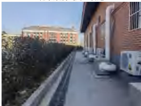
危险废弃物中转站
