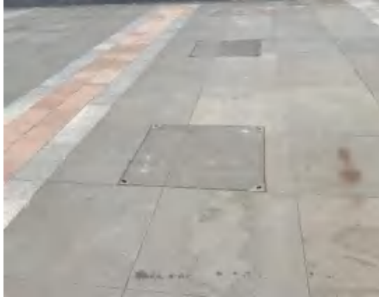
机械大楼南侧化粪池
