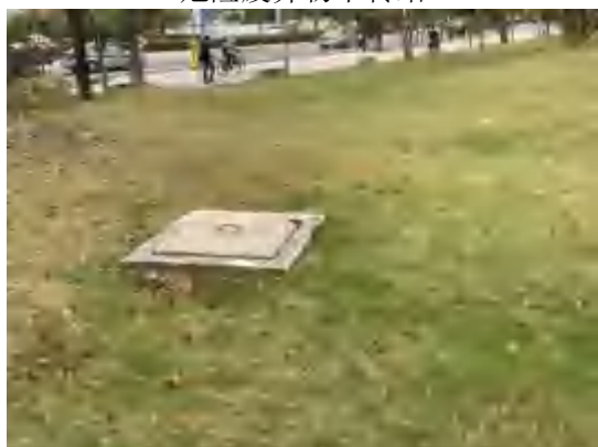
地科学院南侧化粪池
