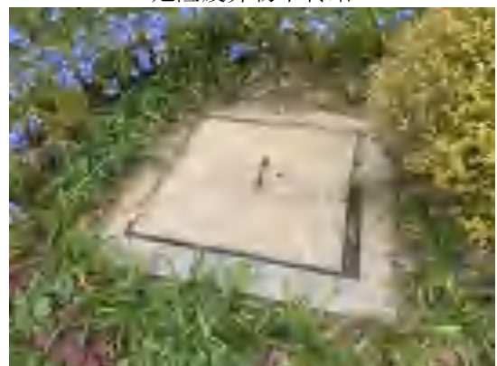
数学学院东侧化粪池
