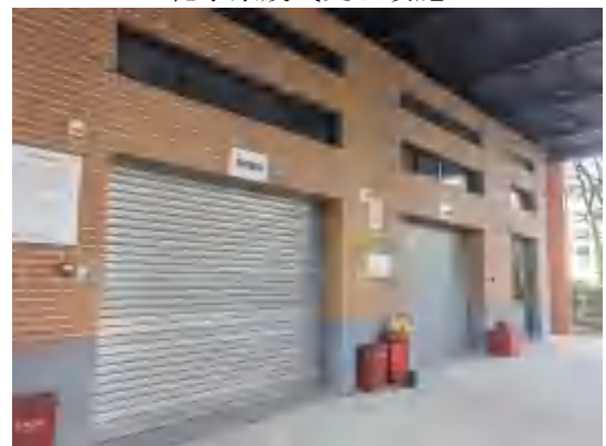
危险废弃物中转站
