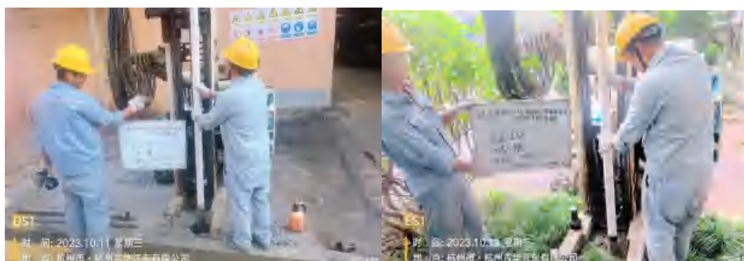
图7.2-5 地下水监测井下管现场照片
