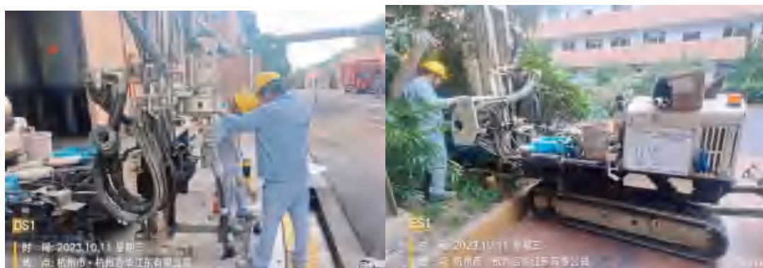
图7.2-4 地下水监测井钻孔现场照片
