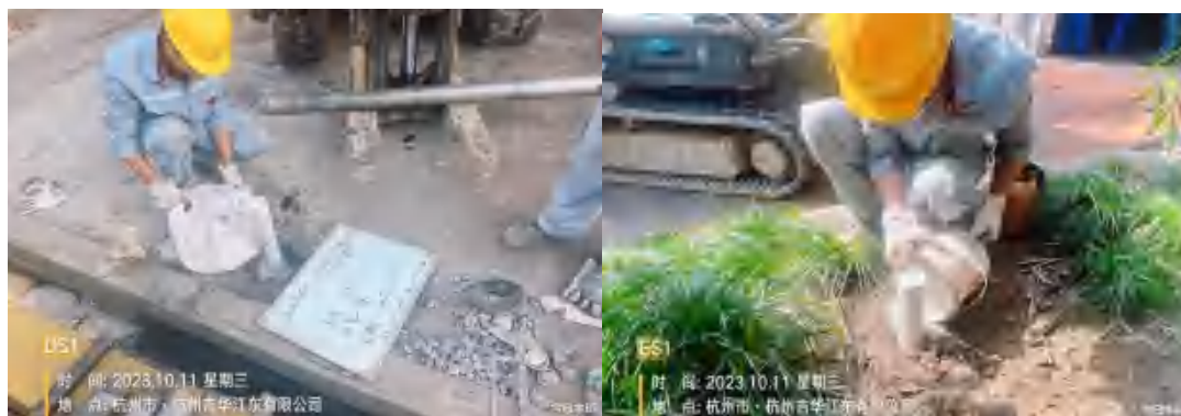
图7.2-6 填砾及止水现场照片
