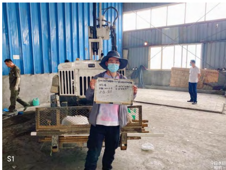
图5.2-1 土壤钻探取样现场照片
