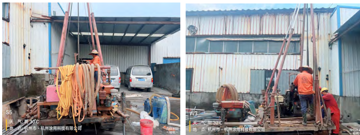
图7.3-1 污水处理站现场情况（门太小，钻机无法进入，点位布设在污水处理站外）
