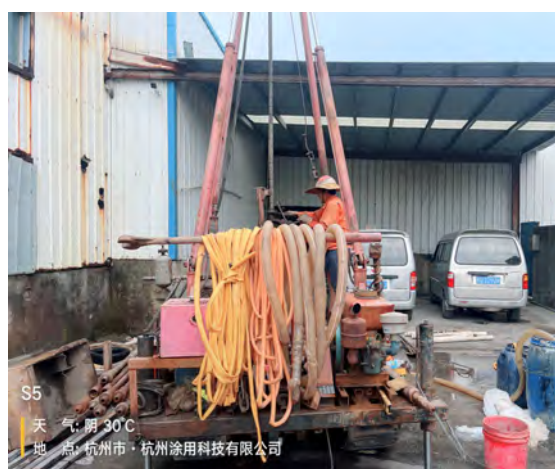
污水处理站外
