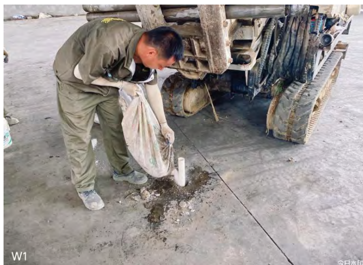
图5.2-5 滤料填充照片
