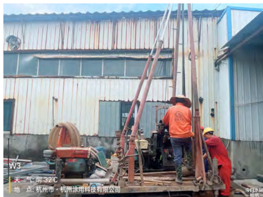
污水处理站外
