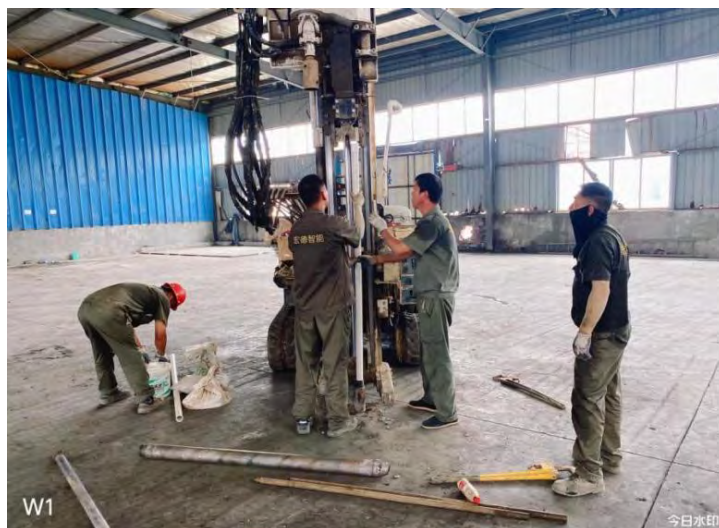
图5.2-4 地下水建井下管照片
