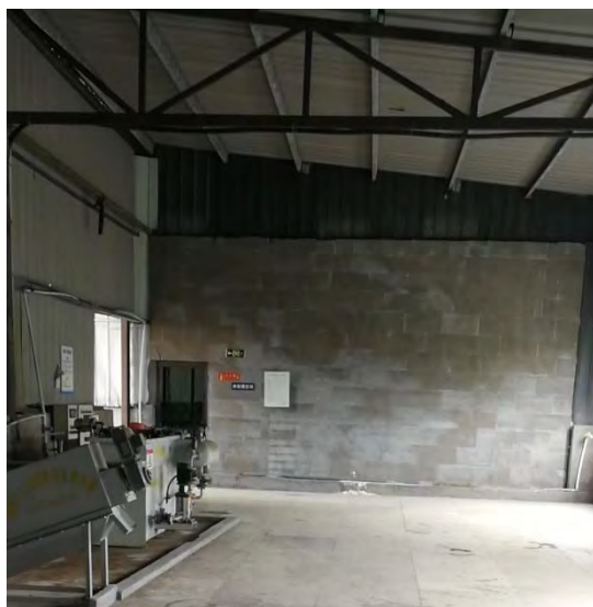
污水处理池旁仓库
