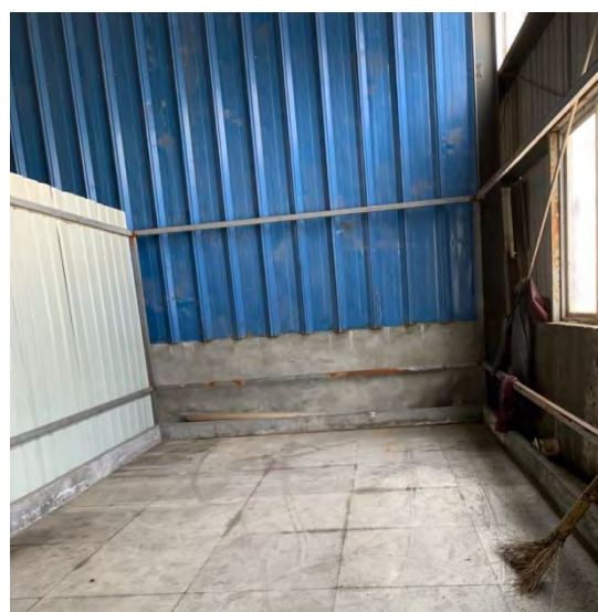
危废仓库内部
