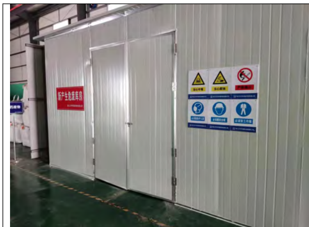
自产危废暂存库（外部）
