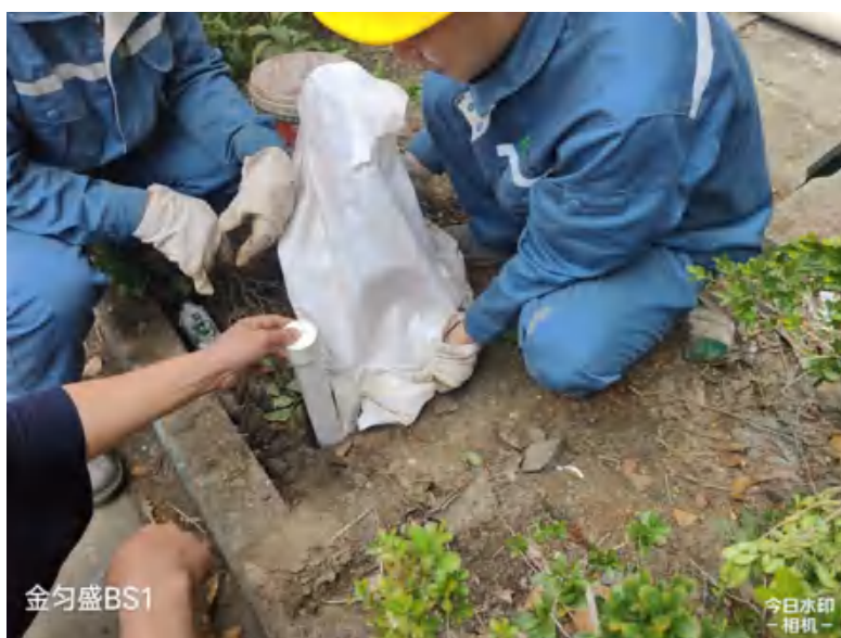
图7.2-2 滤料填充照片
