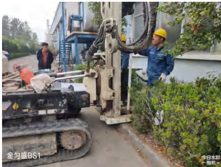
图7.2-1 地下水建井下管照片
