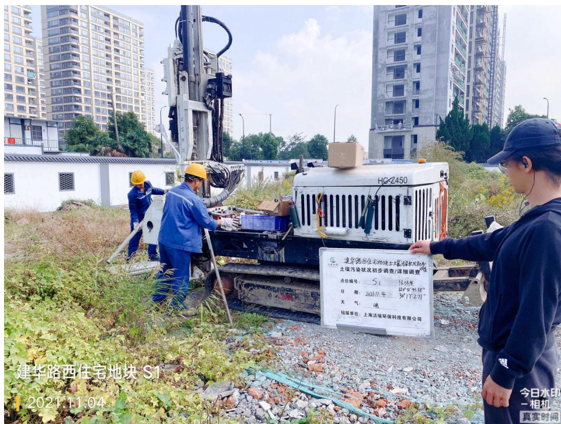
图5.2-1 土壤钻探取样现场照片
