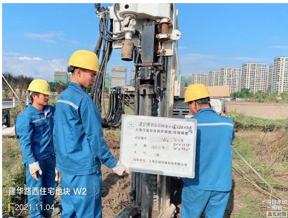
图5.2-4 地下水建井下管照片
