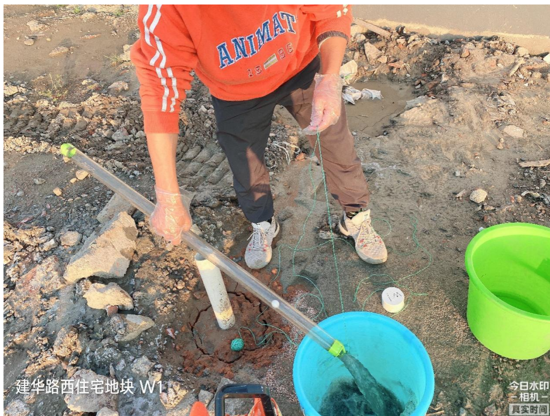
图5.2-7 建井后洗井照片
